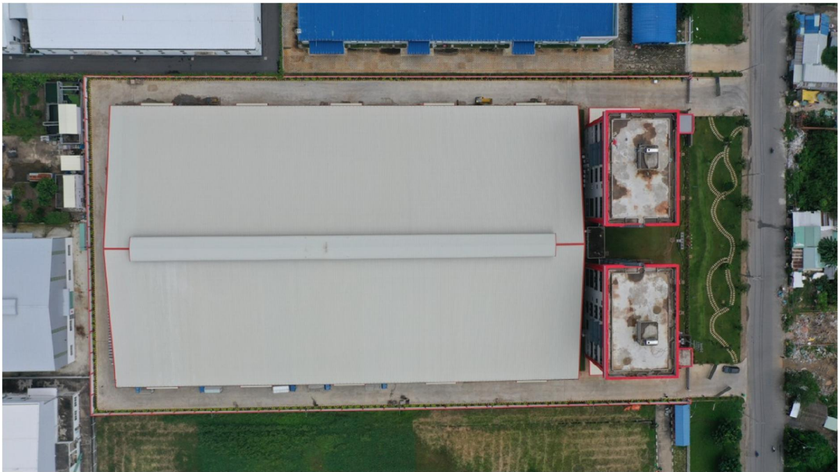
Tổng quan hiện trạng khu vực sẽ lắp đặt tấm pin năng lượng mặt trời
